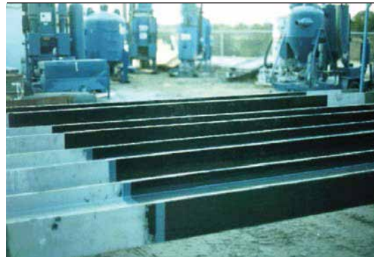
Dos capas de ARC 855 – Al finalizar la soldadura.
